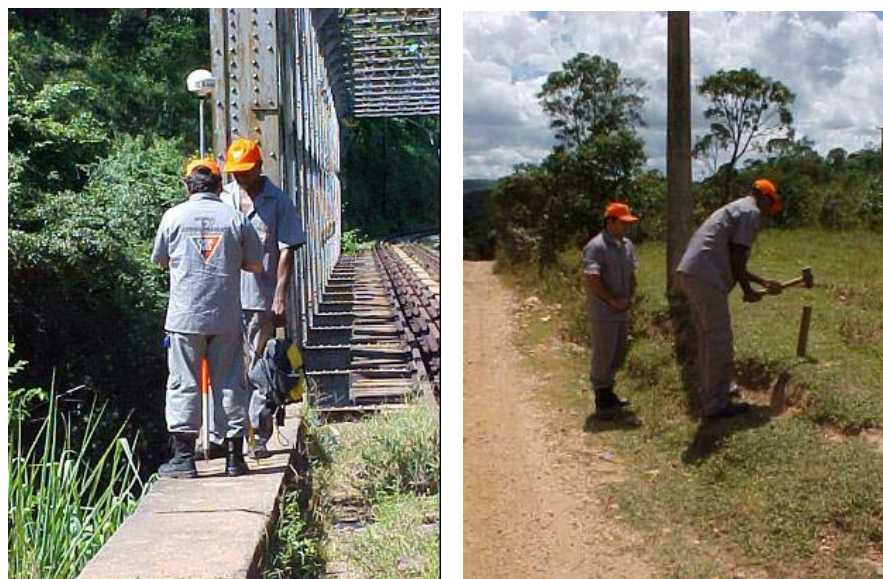
Figura 1 - Equipe DER-MG operando o GPS Geodésico e implantando os piquetes de demarcação da Estrada Real
